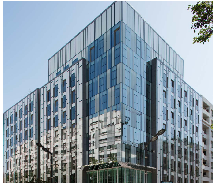
MALRAUX - LEVALLOIS PERRET Bouchaud Architectes | Antonio Maniscalco
