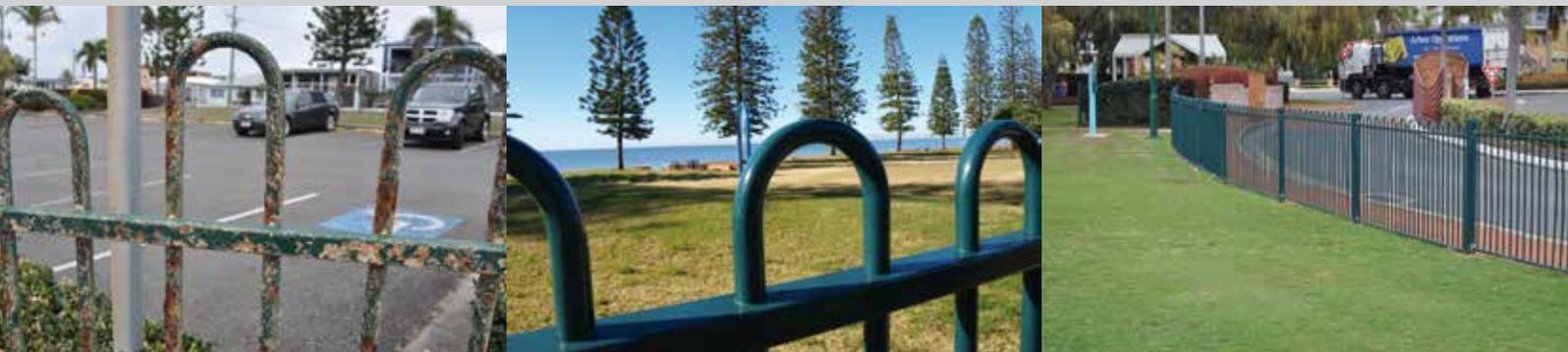
Nel 1996 una società di rivestimento locale di Brisbane raccomandò Plascoat® PPA 571 in un appalto per rimuovere, sabbare, rivestire e reinstallare recinzioni a Sutton Beach, uno dei parchi sul mare di Brisbane. Mentre ci sono voluti solo 6 mesi perché la tecnologia di rivestimento scelta in precedenza si corrodette completamente, le recinzioni rivestite con Plascoat® PPA 571 sembrano come nuove ancora oggi.
